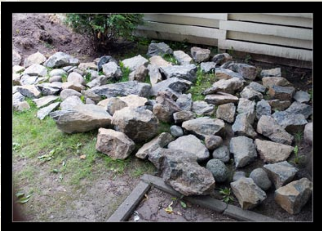
Kivet putouksen rakentamista varten.
