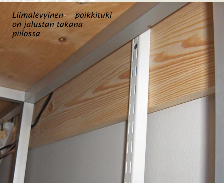
Hylly on nyt pystyssä, mutta se on huterä. Loppusilauksena tulisi olemaan puiset kiilat altaan pöytälevyn ja hyllyn poikkituen väliin.
