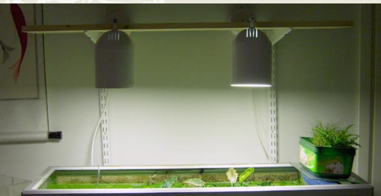
Hylly on nyt pystyssä, mutta se on huterä. Loppusilauksena tulisi olemaan puiset kiilat altaan pöytälevyn ja hyllyn poikkituen väliin.
