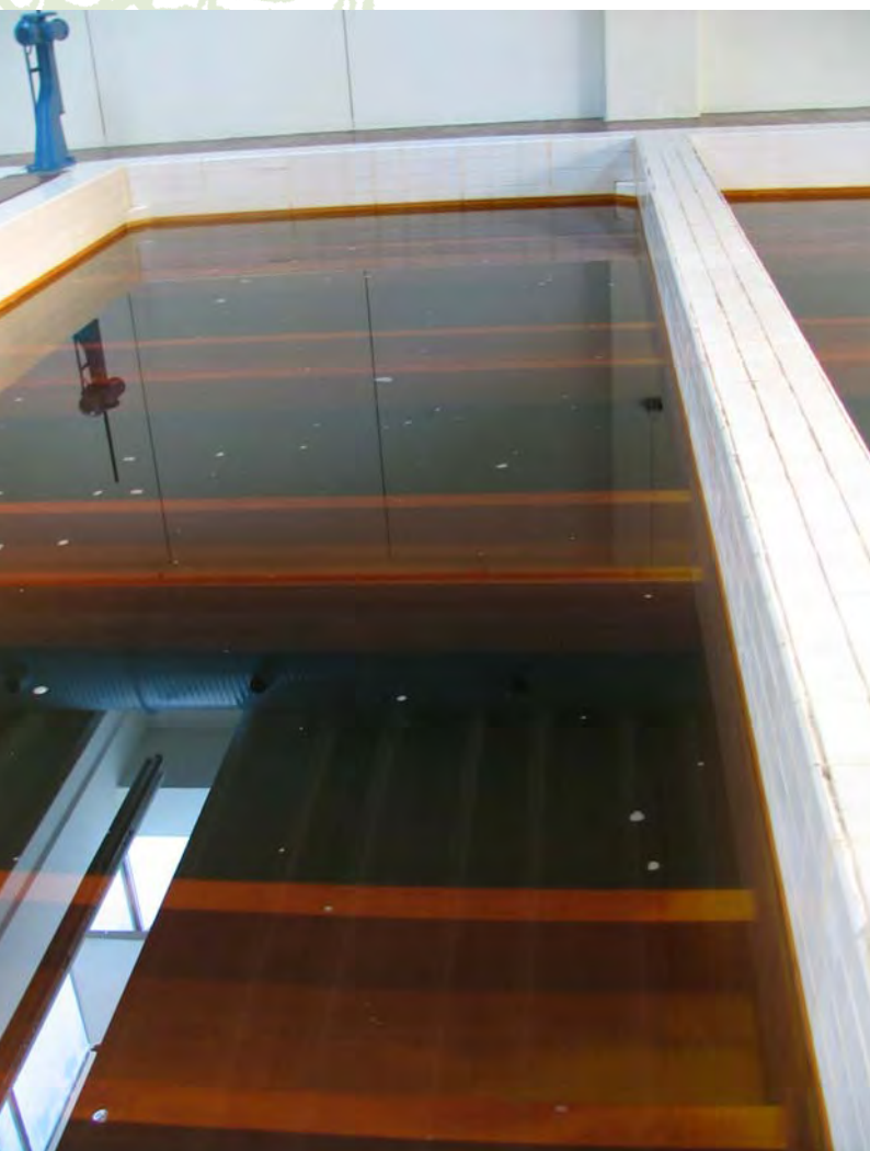
Kuva 2. Esikäsittelyssä muodostunut sakka poistetaan hiekkasuodatusaltaissa.
